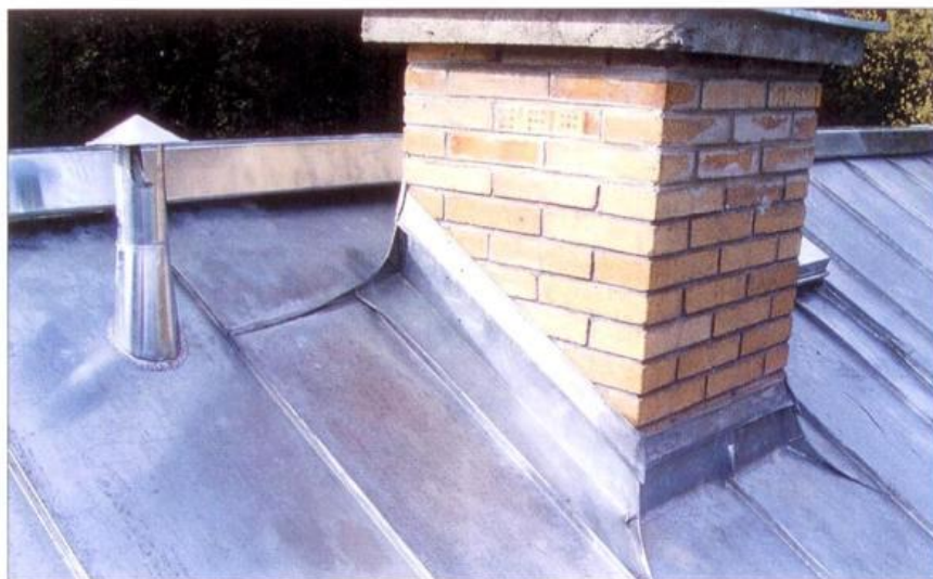
Detail oplechování komína a ventilačního průduchu.
